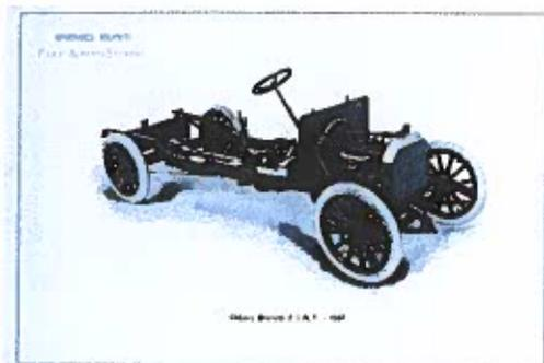
vari tipi di telai rispetto alla lunghezza. Su di essi può adattarsi qualsiasi tipo di carrozzeria. Gli *Assali* sono di acciaio speciale, forgiati.
