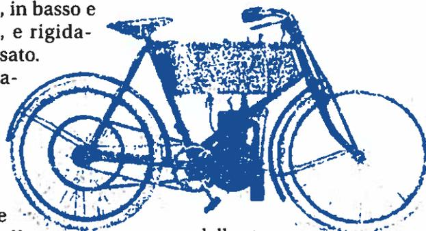
presso alla culatta. Questo carburatore possiede una valvola di strozzamento per mezzo della quale si può regolare l'ammissione del gaz al cilindro. Un grande serbatoio contiene benzina, olio, accumulatori e bobina, di più di fianco a questo recipiente, nella parte anteriore, sta un piccolo oliatore a pompa che permette di lubrificare il motore durante la marcia.
